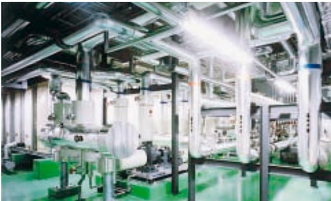
▲変電所やビルの排熱などを有効活用し造られた冷温水(DHC)を使用した冷暖房システムを採用しています。
