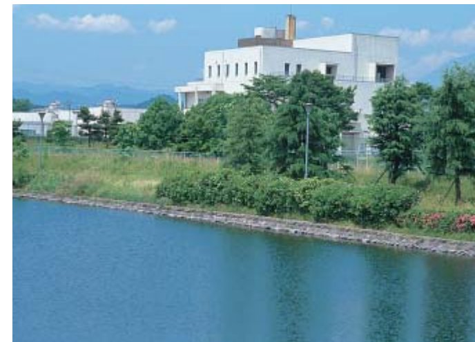
汚泥処理施設
