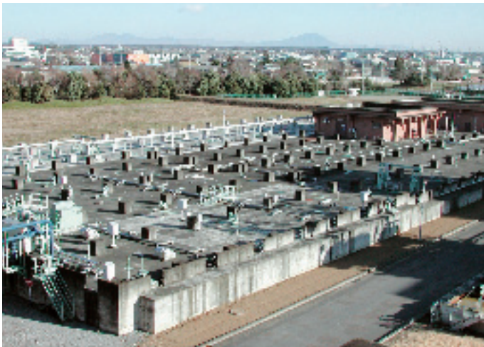
水処理施設全景
