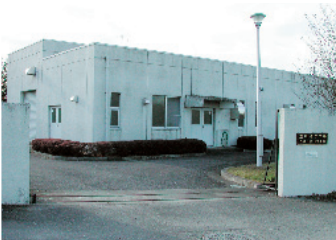
思川中継ポンプ場
