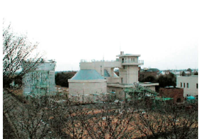
汚泥消化設備
