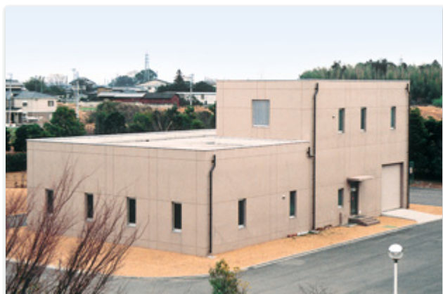
沈砂池ポンプ棟
