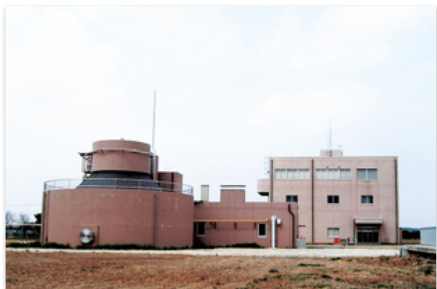
汚泥消化槽・汚泥処理棟
