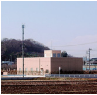
岩舟中継ポンプ場
