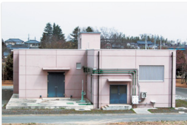
放流ポンプ棟（地下：塩素混和池）
