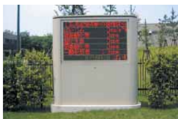
⑥電光掲示板 焼却炉・溶融炉の排ガス濃度を常時測定し、屋外の電光掲示板に表示して公開します。
