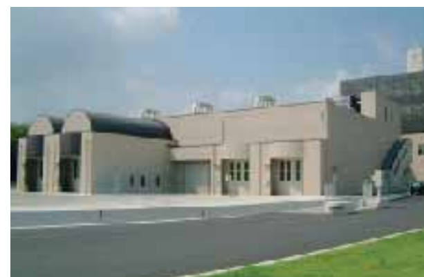
②受入貯留棟（前景） 収集した脱水汚泥等を受け入れます。二重扉など臭気を逃がさない工夫をしています。
