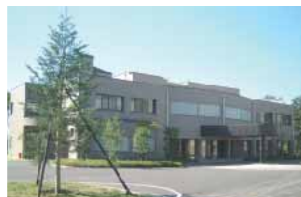
①管理棟 資源化工場施設の総合管理を24時間体制で行います。
